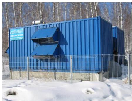
Рис. 4.24. Дизель-генераторная установка типа ADDo-500: а – общий вид; б – дизель; в – генератор; г – блок-контейнеры
