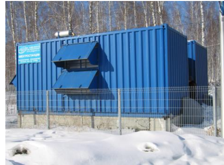
Рис. 8.4. Дизель-генераторная установка типа ADDo-500: а – общий вид; б – дизель; в – генератор; г – блок-контейнеры
