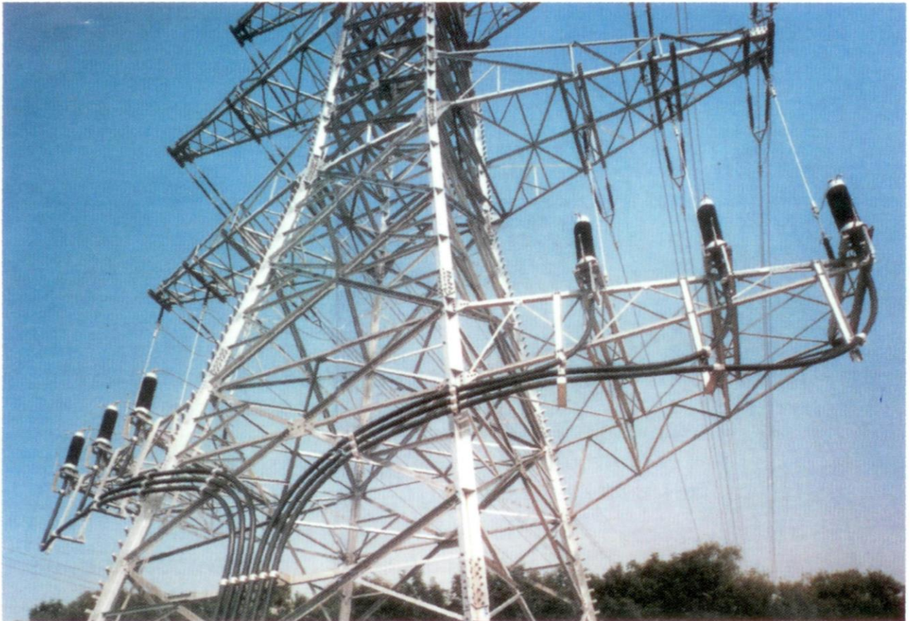
5.40. Переход КЛ-110 кВ на ВЛ-110 кВ
