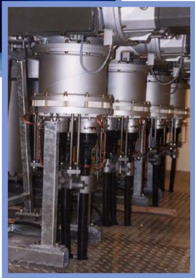
Рис. 5.22. Газонепроницаемое компактное концевое уплотнение кабеля
